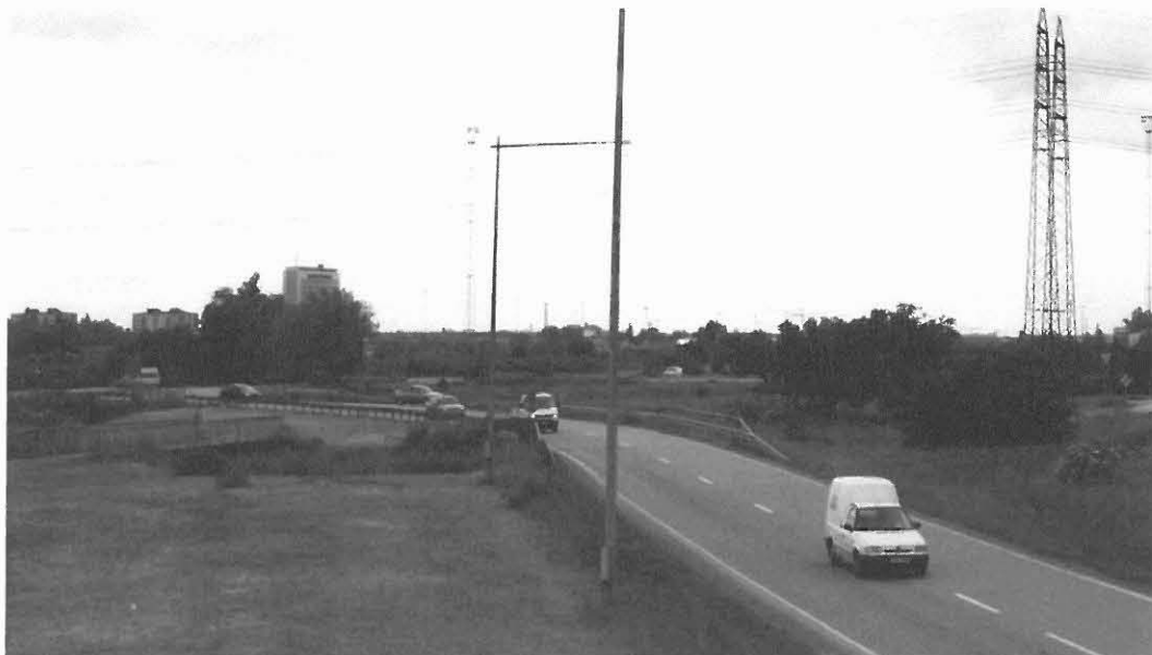
Trafikplats Spillepengen från norr
